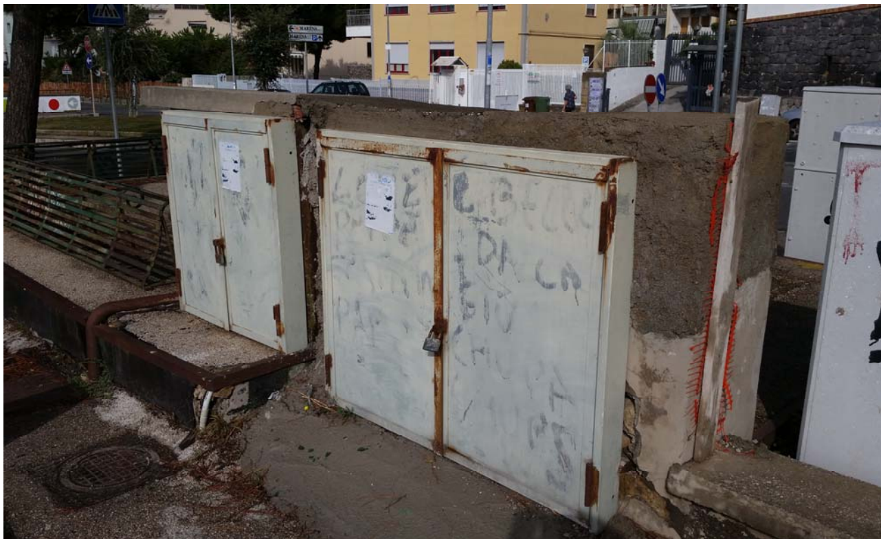
Fotografia 05 – Vista esterna dei quadri elettrici
